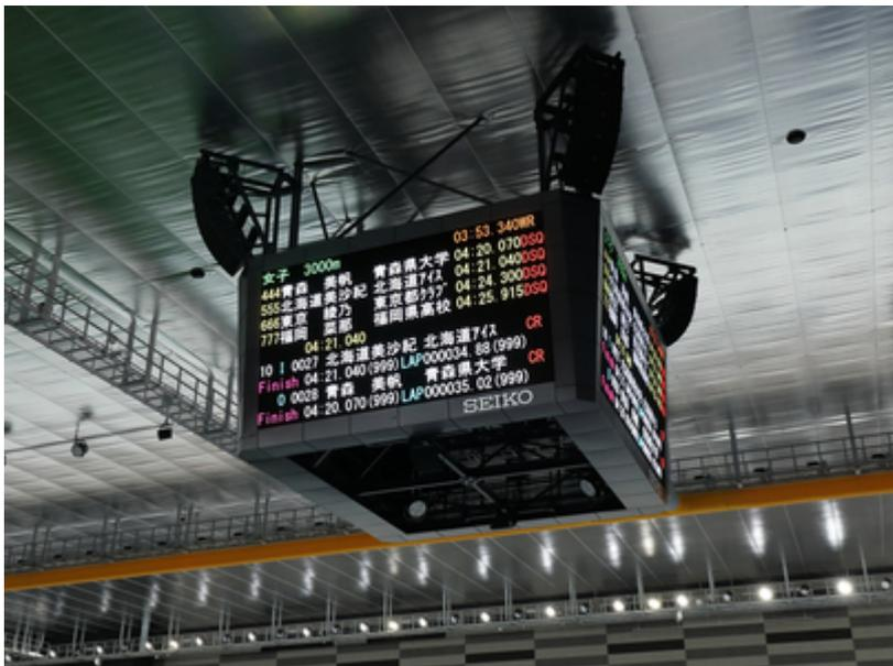
2019年9月、八戸市長根公園内に誕生した「YSアリーナ八戸」。長野、帯広に続き、国内3ヶ所目となるスピードスケートの公式競技会が開催できる屋内スケート場です。「氷質」「空調環境」「照明環境」にこだわり、国際大会にも対応した世界水準の400メートル標準ダブルトラックを備えています。また、リンク解氷時には、約 14,000㎡のアリーナとして、コンサートやコンベンション、各種展示会会場としても利用できます。天井吊下型の大型LED表示盤には、8mmピッチの高精細なSMD型フルカラーLED素子を採用。視認性に優れた文字表示と鮮やかな映像表示で感動のスポーツシーンやイベントをドラマチックに演出します。
