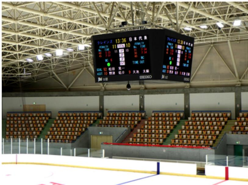
「氷都くしろ」のアイスホッケー拠点、釧路アイスアリーナ。従来から設置されていた電球式の4面吊下型電光表示システムの更新工事が行われ、鮮やかなフルカラーLED式の大型映像表示装置に生まれ変わりました。10mmピッチの高精細なSMD型フルカラーLED素子を採用し、得点・ペナルティ・時間等の競技表示の他、グラフィックメッセージやテキストメッセージ、ライブ映像を含めた多彩な表示を実現。フリーボードのメリットを活かした画面分割機能もあります。新しい大型映像表示装置の完成により、試合を一層盛り上げ、ドラマチックに演出する効果が期待できます。
