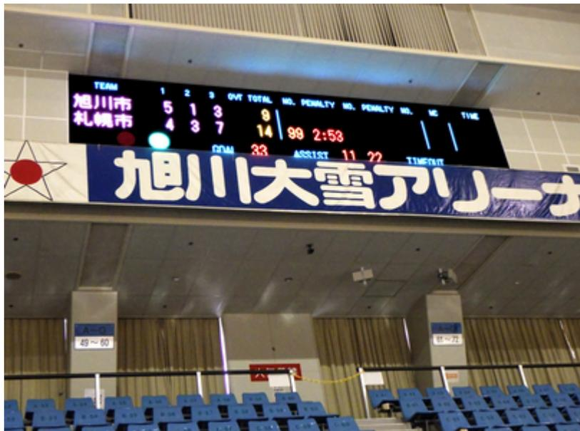
【表示面】 W7,168 × H1,280mm (約9.2㎡) ※両サイドに2基設置
